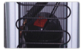
密封的往复式压缩机
